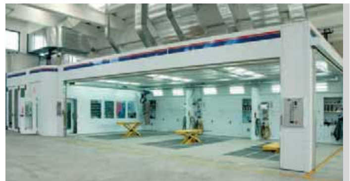
Boya kabinlerine uygulama
