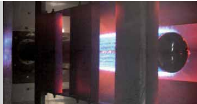
Boya kabinlerine uygulama: eşanjör kanalı iç görünüşü
